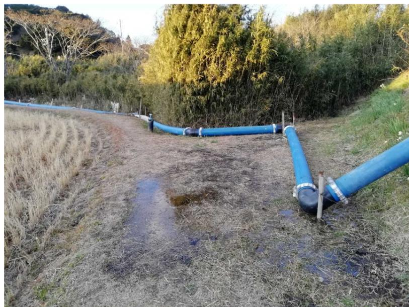
図8 (写真) 仮設配管敷設完了
