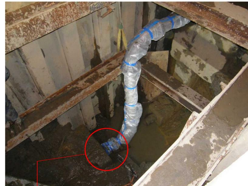
図5 (写真) 修繕箇所配管完了
