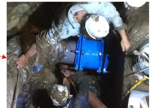
図6 (写真) 異種管継手
