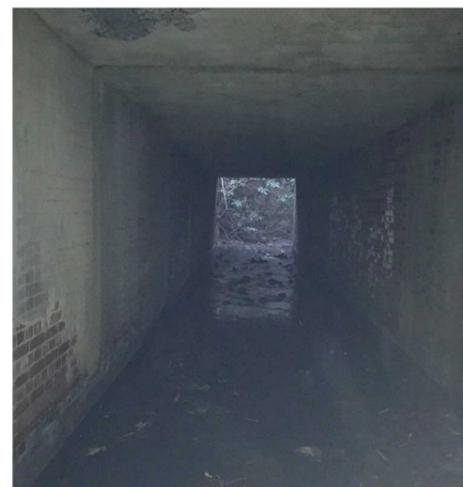
図9 (写真) 軌道下ボックスカルバート<sup>※</sup>
